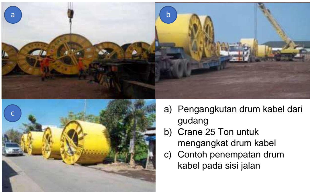
Gambar 2. 53. Mobilisasi dan Penempatan Drum Kabel
