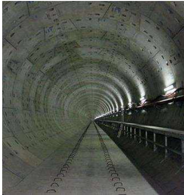
Gambar 2.17 Lantai Terowongan MRT
