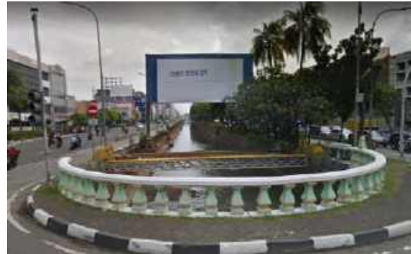
b) Kondisi Air Permukaan di Lokasi Stasiun MRT Jakarta Sawah Besar
