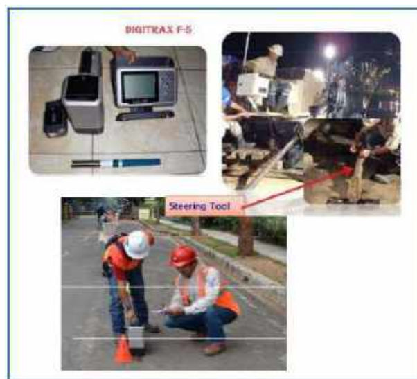
Gambar 2.46 Ilustrasi Pengontrol Arah Pengeboran dengan Digitrax
