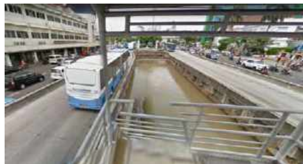
c) Kondisi Air Permukaan di Lokasi Stasiun MRT Jakarta Harmoni
