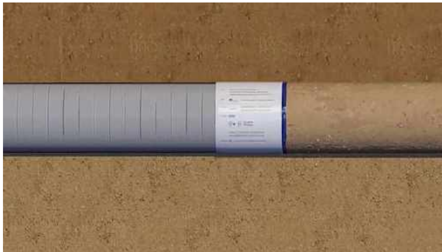
Gambar 2.11 Penggalian Tanah dengan TBM
